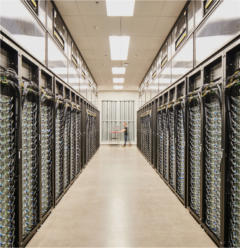
Apple 里诺数据中心于 2012 年投入运营，充分利用当地温和的气候，尽可能用外部空气冷却服务器。
